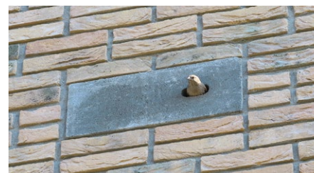
Huismuskasten in gevels.
