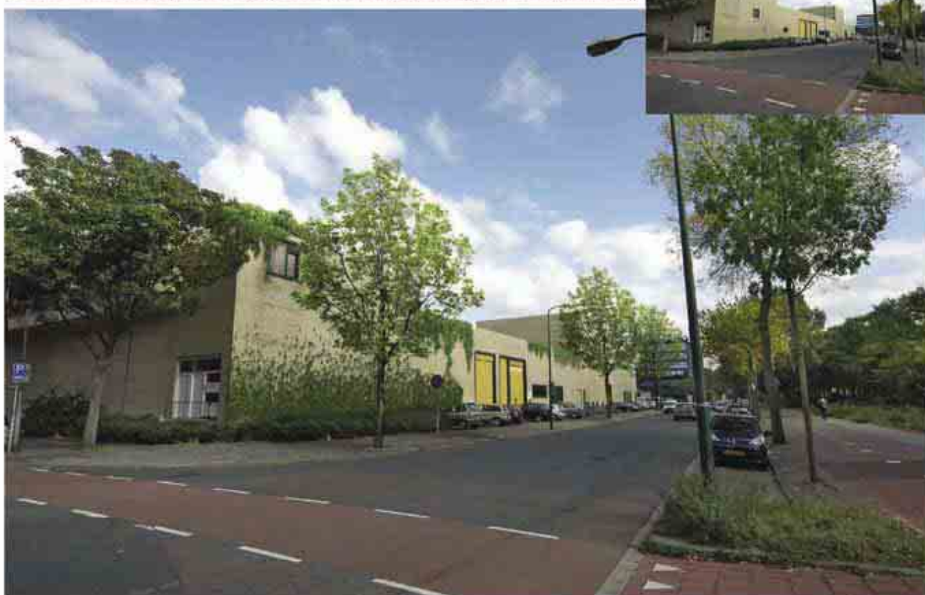
L2: Voor en Na: Mogelijkheden groene daken en groene gevels Lange Kleiweg
