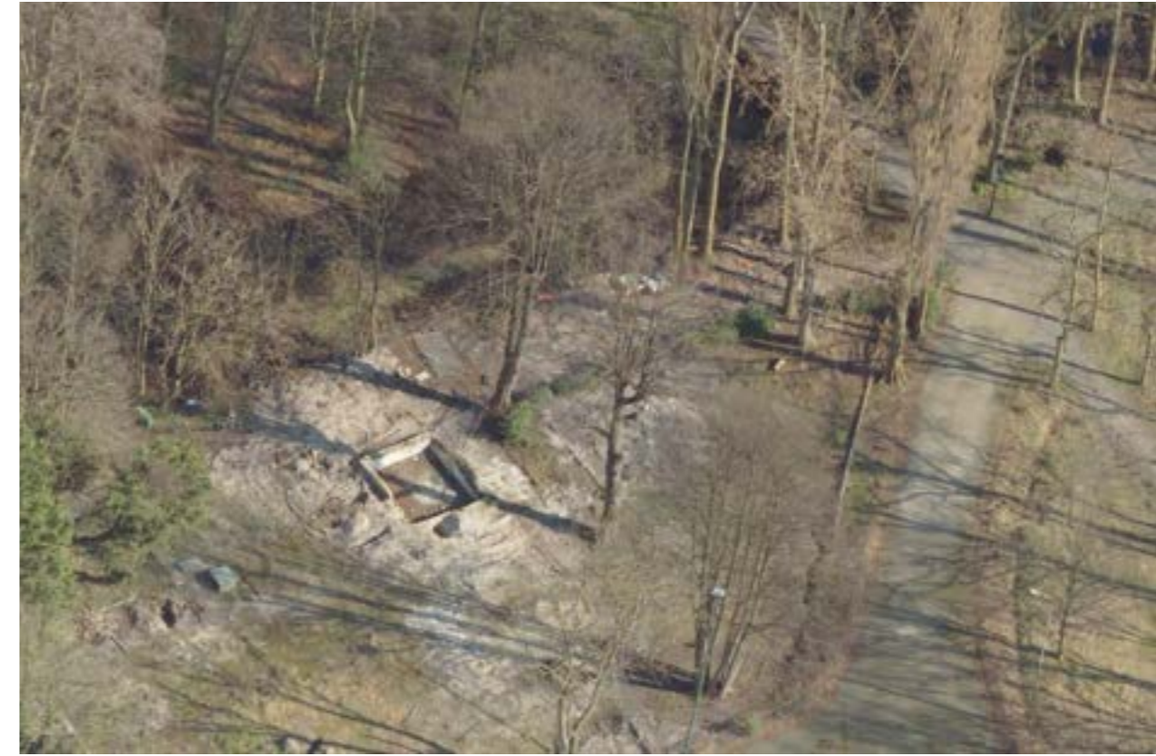
Locatie hofstede na de sloop, met de resterende lindebomen
